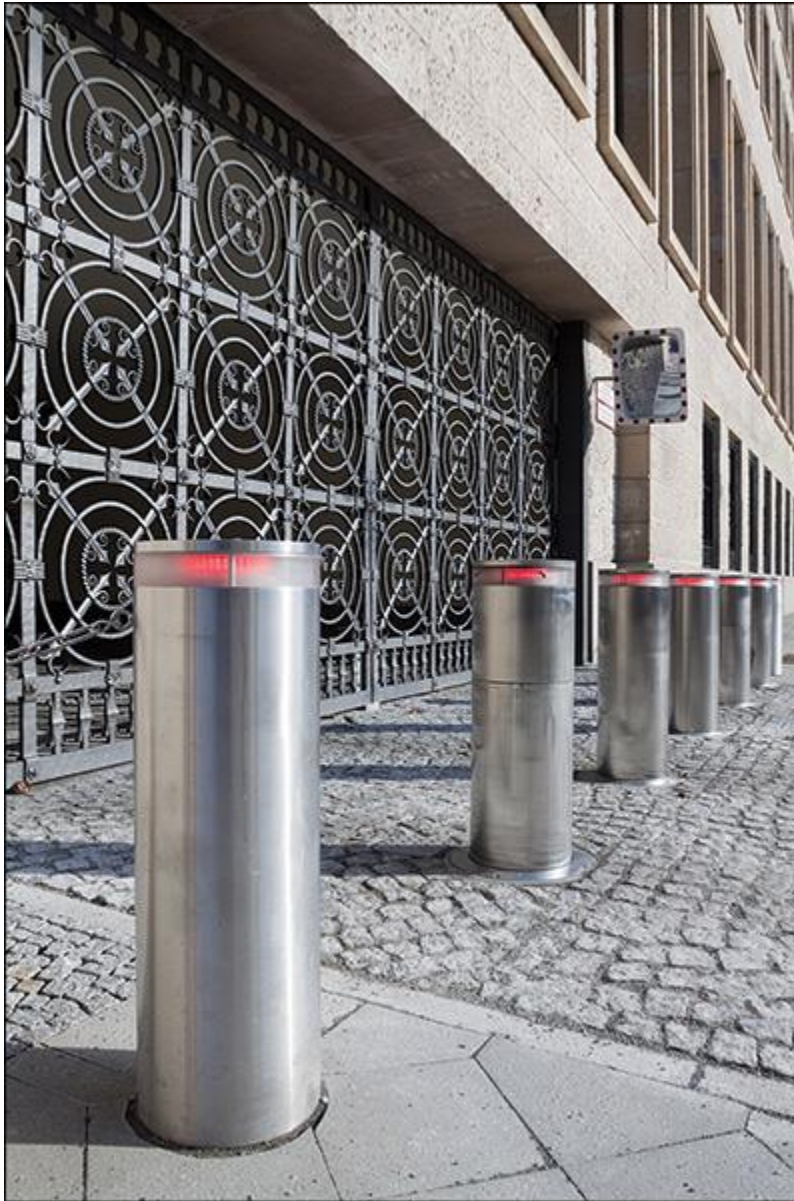
Figura 7-14 Bolardos de acero
